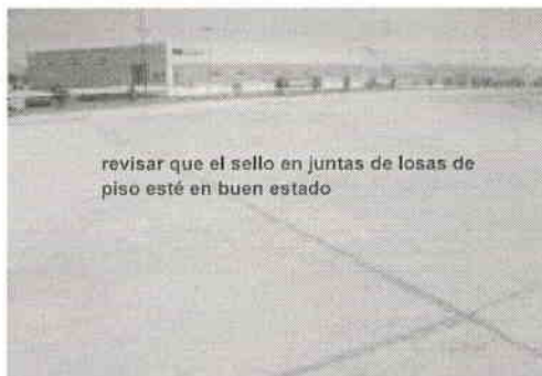
VIALIDADES CON CONCRETO
